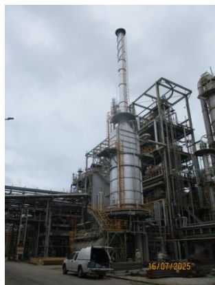
ปล่อง HTS Furnace Off Gas
